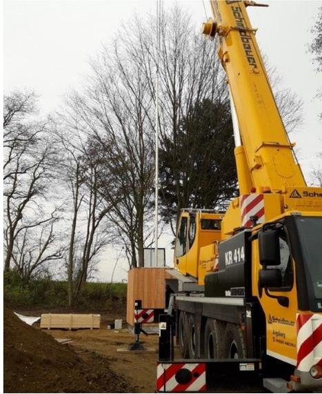
verlängerung des Brunnens, neue hydraulische Installationen, eine neue leistungsfähigere Brunnenpumpe, eine neue Brunnenstube sowie eine komplett neue elektrische Brunnenanlage (Schaltschränke, Elektronik ...). Dieser Einsatz wurde noch im Dezember 2017, nach circa drei Monaten, beendet. Kostenfaktor: circa 524.000 Euro.
