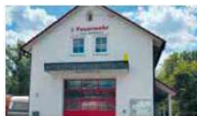
Pichl Feuerwehrhaus V.-Schaezler-Straße 21, 86447 Aindling
